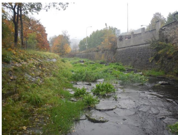
Rovnanina z plochého kamene ve dně nad mostem Bynovská
