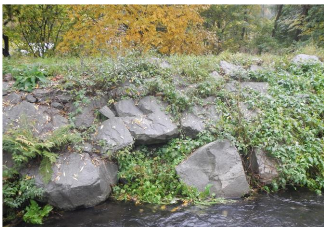
Místo s částečně odplavenou kamennou rovnaninou.
