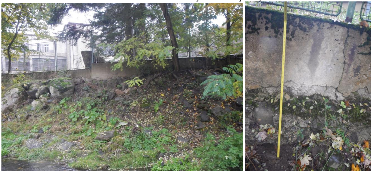
Náporový břeh s porušenou kamennou dlažbou a zídkou v horní hraně.
