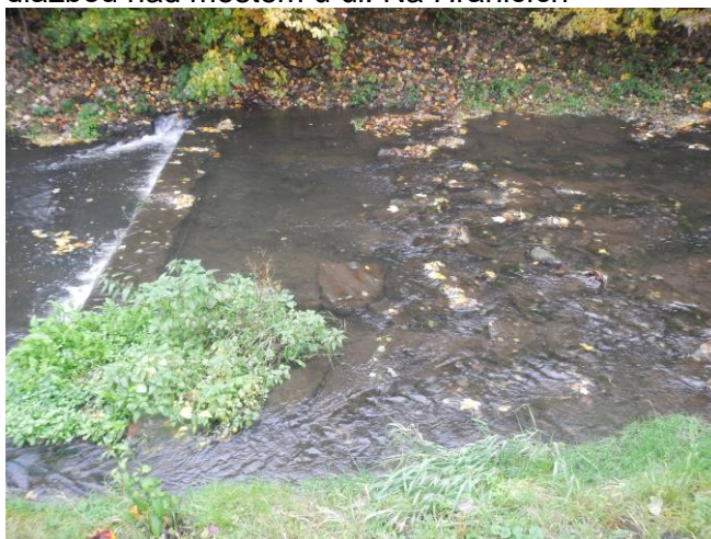
Poškozené dno nad přelivným prahem stupně u zahrádkářské kolonie
