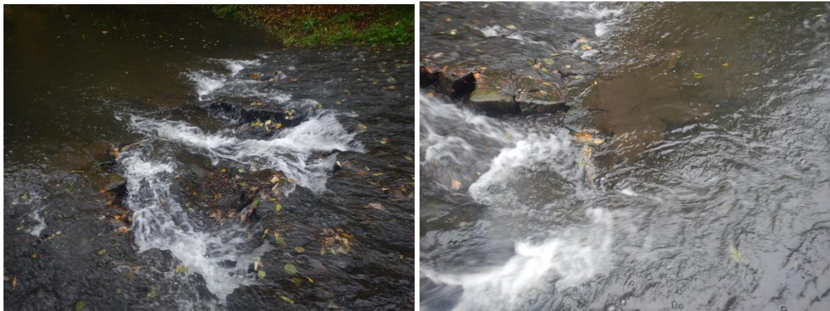
Porucha na nátoku do usazovací tůňky. Porucha navazuje na poškozené opevnění pod hladinou.
