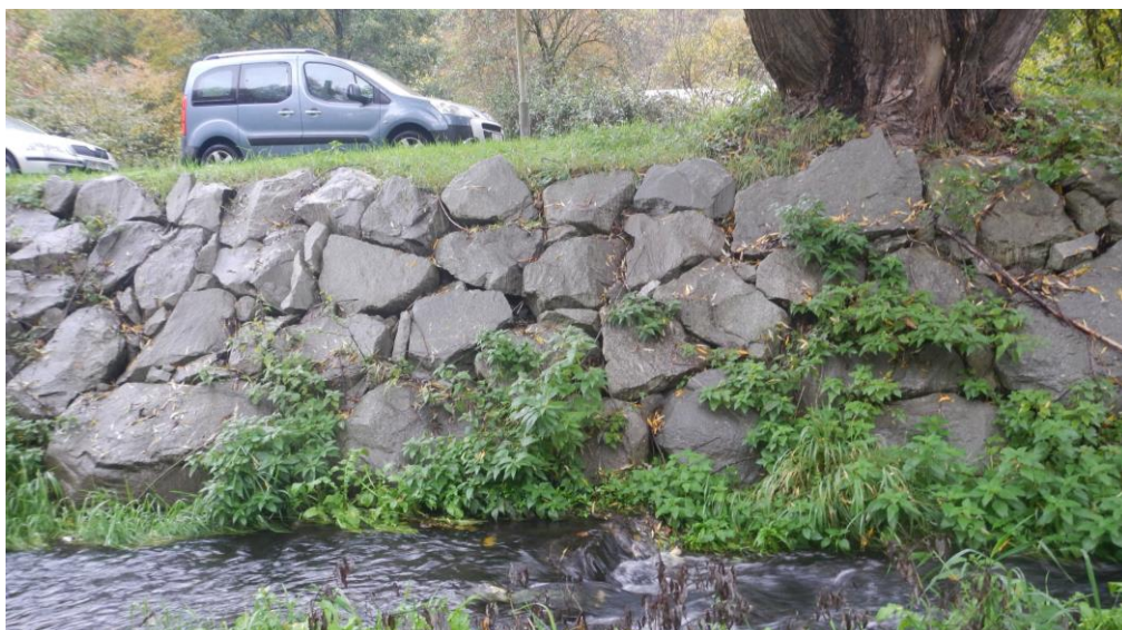
Místo s výraznými volnými spárami mezi kameny rovnaniny. Patrná absence záhozové paty.
