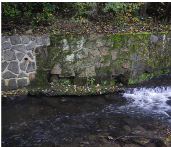
Poškozená část náporové zdi.
