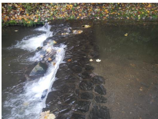
Příčný práh stupně zděný z čedičového kamene
